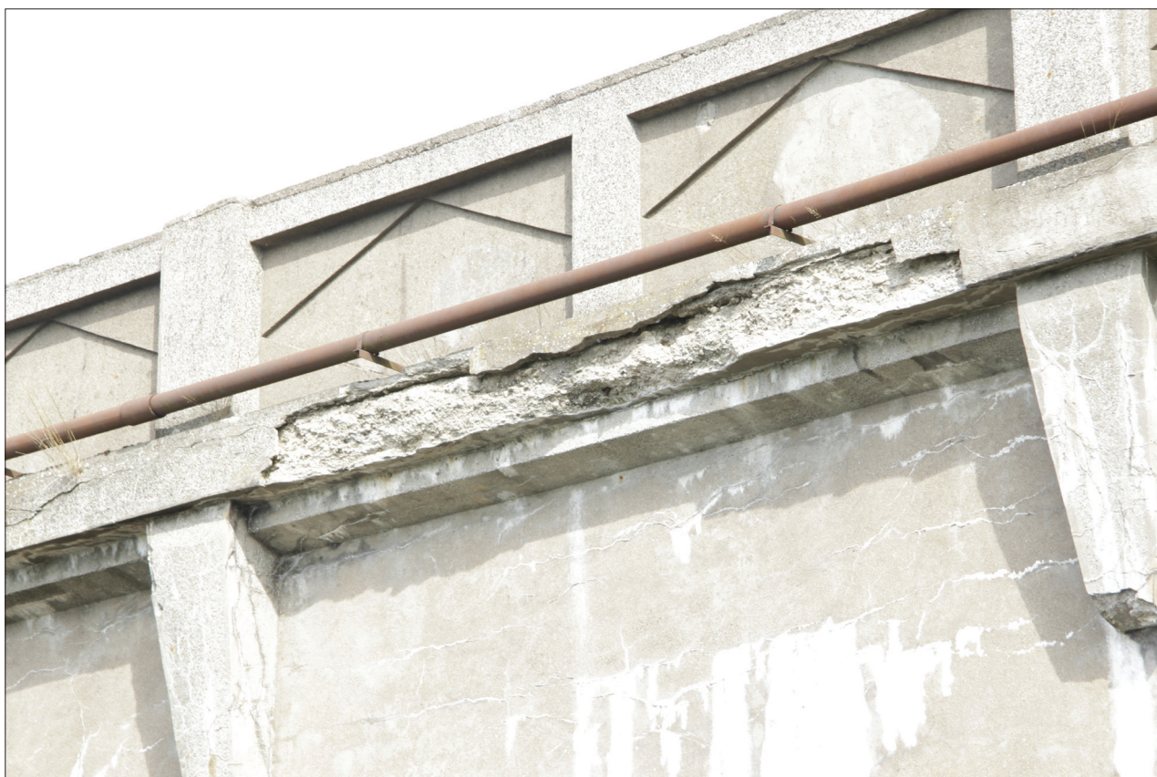
36. Detail degradované nosné konstrukce na povodní straně jižního pole
