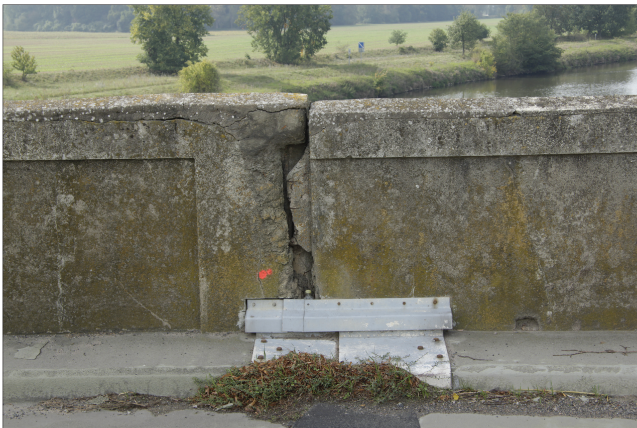
43. Detail rozrušeného povrchu u dilatace severního a středního pole na západní straně
