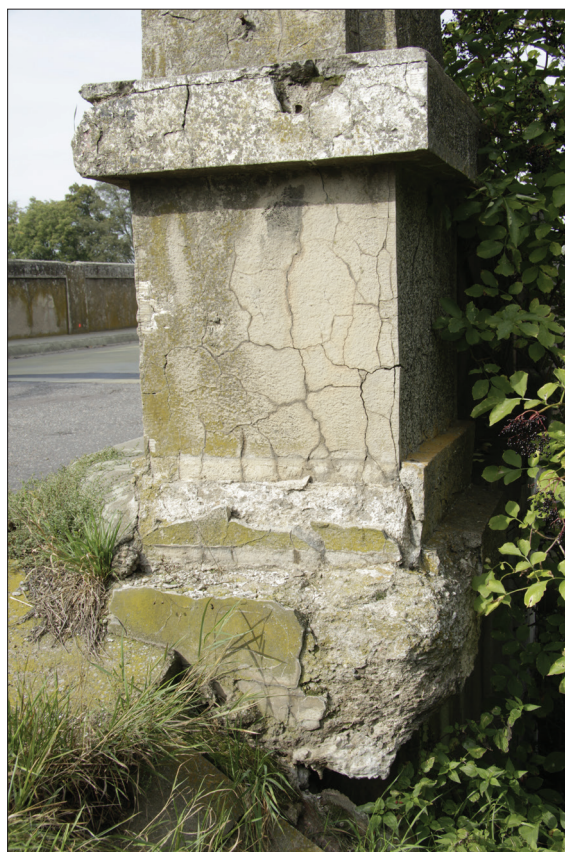
40. Detail degradovaného soklu východního pylonu jižního předmostí
