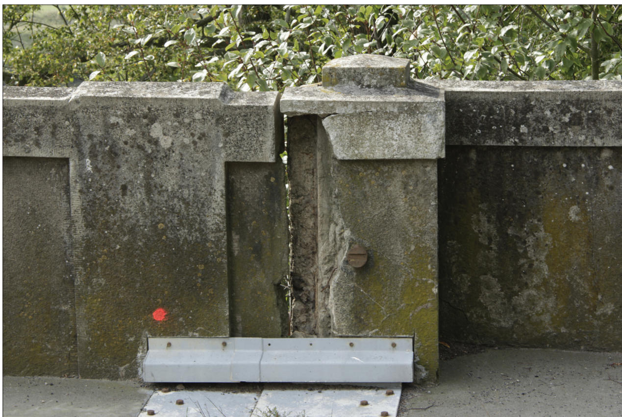
44. Detail výrazného narušení zábradlí u pilířku severního přemostí na západní straně
