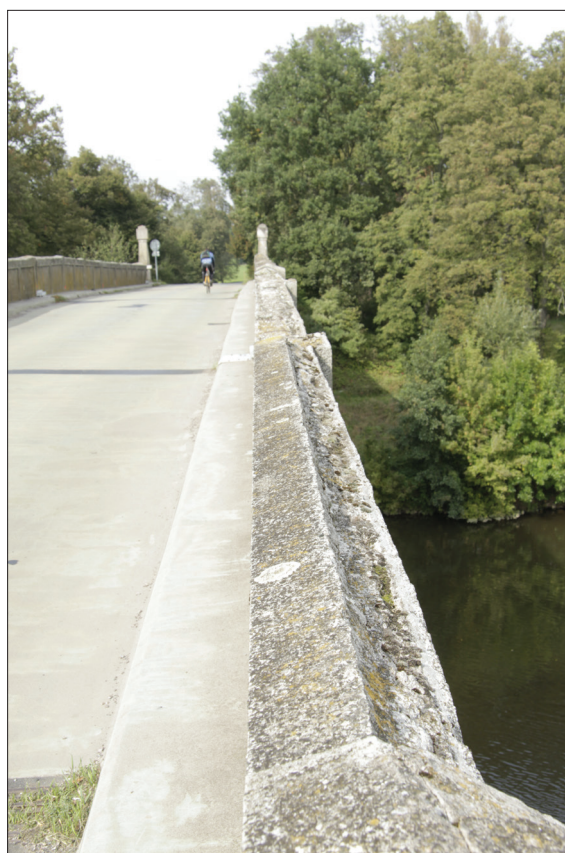
42. Detail degradovaného madla zábradlí na východní straně
