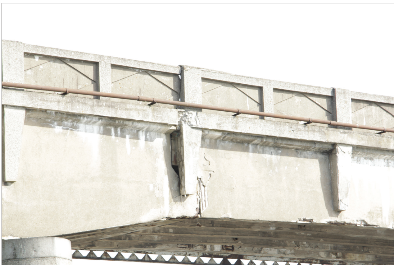
38. Detail trhlin a degradace kolem dilatační spáry mezi severním a středním polem na povodní straně
