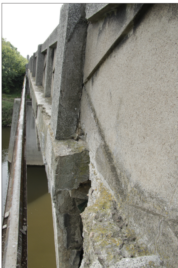
41. Detail degradované římsy a konzoly na návodní straně u jižního krakorce
