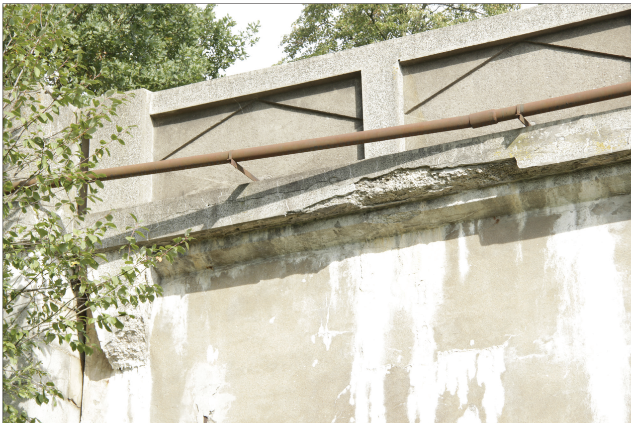
37. Detail degradované římsy a konzoly u západní strany severního pole
