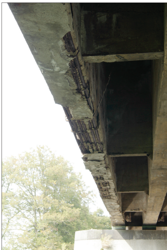
39. Detail degradace trámu a výztuže na jižním poli
