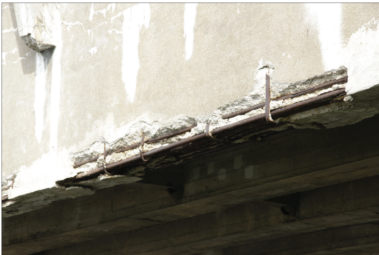
35. Detail degradované nosné konstrukce na povodní straně severního pole
